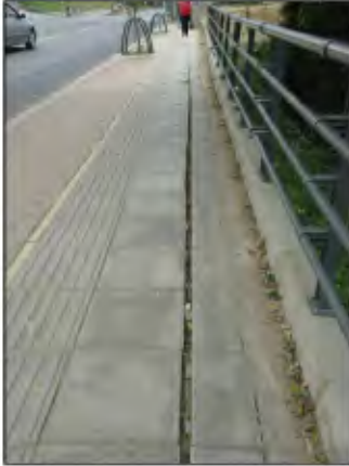
1) ESPACIO PÚBLICO: LOSETAS Y BARANDAS
