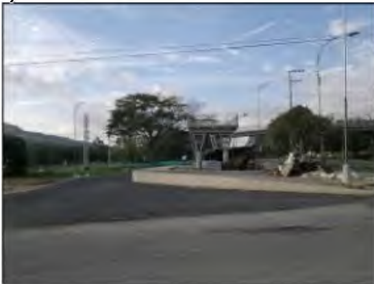
5) PLATAFORMA DE TRANSFERENCIA: MUROS
