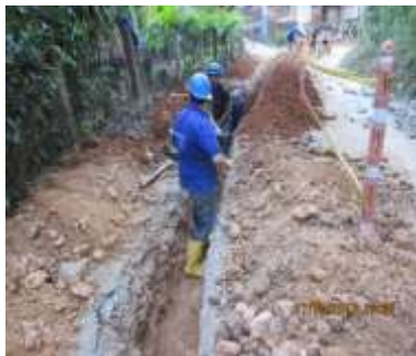
INSTALACION DE TUBERIA BARRIO GRANJAS DE PROVENZA PARTE BAJA
