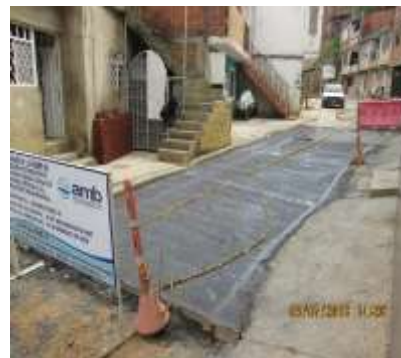
RECONSTRUCCION PAVIMENTO GRANJAS DE PROVENZA PARTE BAJA
