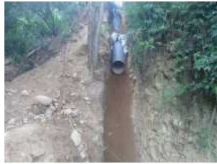
CONSTRUCCION LINEA DE CONDUCCION TANQUE SAN JUAN- AUTOPISTA GIRON
