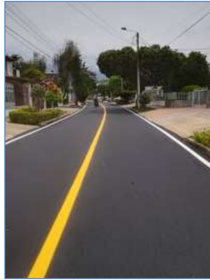
RECUPERACION DE PAVIMENTO, COLOCACION SELLO Y SEÑALIZACION VIAL BARRIO DIAMANTE II
