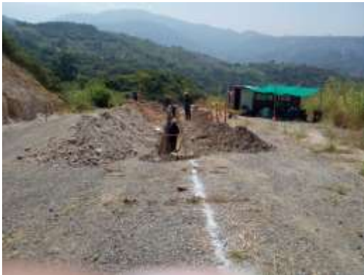
EXCAVACIONES E INSTALACION DE TUBERIA EN HIERRO DUCTIL D=10"
