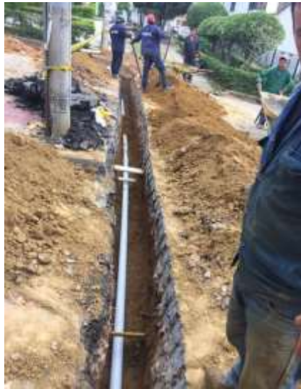
INSTALACION DE TUBERIA BARRIO DIAMANTE II
