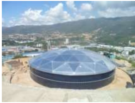
TANQUE DE ALMACENAMIENTO LA ESMERALADA
