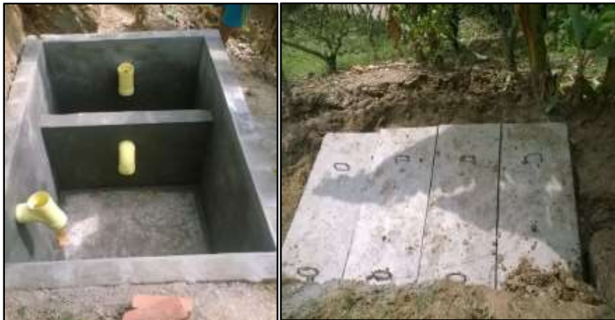
POZO SEPTICO EN CONTRUCCIÓN
