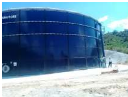
TANQUE DE ALMACENAMIENTO LA ESMERALADA
