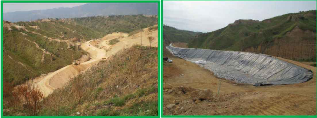
Dique construido e impermeabilizado se encuentra en un 90 % de la ejecución
